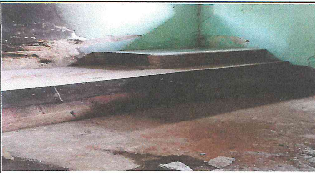
Foto 3: Sustitucion de planchas de cocina
