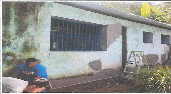
Foto1: Vista del remozamiento de ventanales y pared de la cocina
