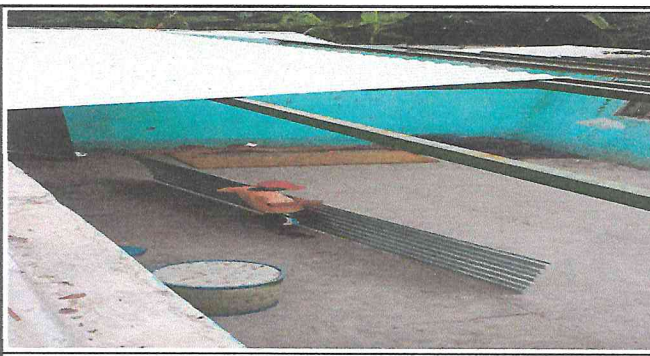
Foto 5: Vista de aula sustitucion de lamina troquelada
