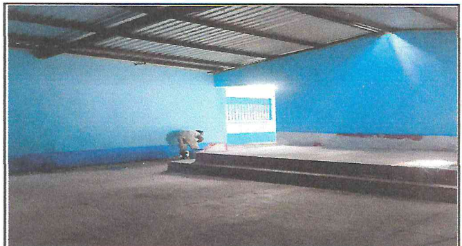
Foto 4: Repello, cernido y pintura en paredes
